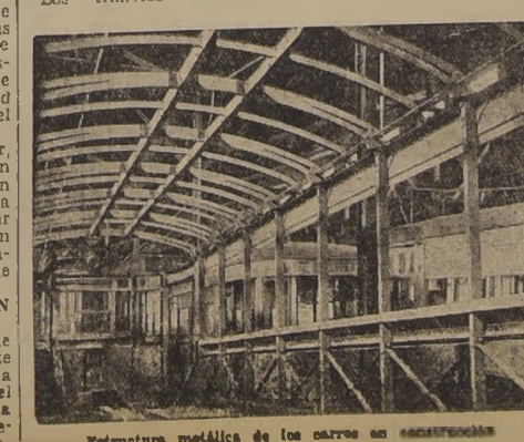
Estructura metálica de los carros en construcción
