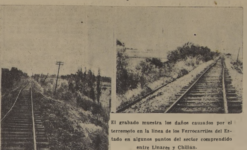
El grabado muestra los daños causados por el terremoto en la línea de los Ferrocarriles del Estado en algunos puntos del sector comprendido entre Linares y Chillán.
