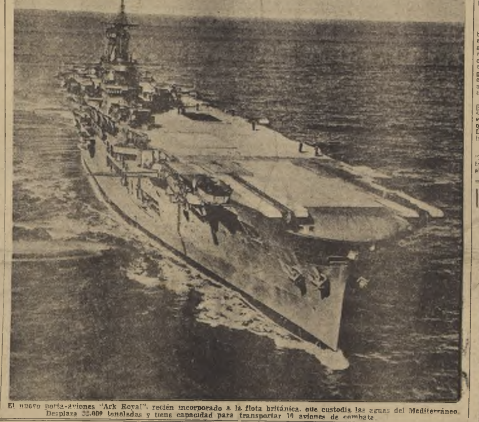
El nuevo porta-aviones "Ark Royal", recién incorporado a la flota británica, que custodia las aguas del Mediterráneo. Desplaza 34.000 toneladas y tiene capacidad para transportar 70 aviones de combate.
