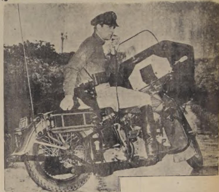
Las policías del tránsito por caminos en California están usando actualmente unas motocicletas que están provistas de los más modernos elementos de comunicación, fotografía, etc. Por ejemplo, el policía que se ve en este grabado lleva en su máquina un aparato de radio receptor y transmisor a la vez; una cámara fotográfica tipo Leica con un potente reflector para vistas nocturnas, e innumerables otros aparatos eléctricos que harían la delicia de Edison. Sobre la rueda posterior puede verse la antena de la radio.
