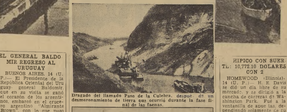
Dragado del llamado Paso de la Culebra, después de un desmoronamiento de tierra que ocurrió durante la fase final de las faenas.
