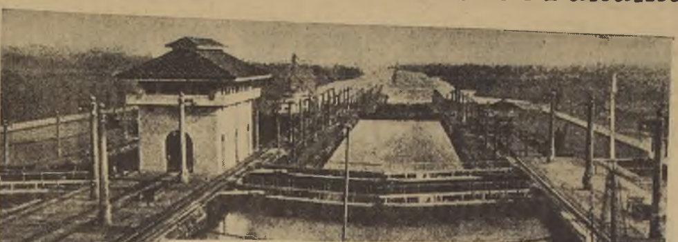
Hoy se cumplirán 25 años desde la primera travesía del canal por un barco, después que la obra fué entregada al servicio, el 15 de agosto de 1914. Panorámica mirando hacia el Atlántico, que muestra la parte superior de las esclusas de Gatun y sus alrededores.
