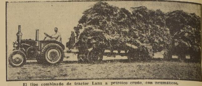
El tipo combinado de tractor Lanz a petróleo crudo, con neumáticos.
