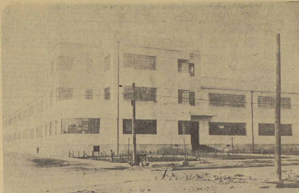
El magnífico edificio de la Escuela "Mapocho", con capacidad para 3.000 alumnos, y que será inaugurado en la próxima semana, con asistencia de S. E. el Presidente de la República.
