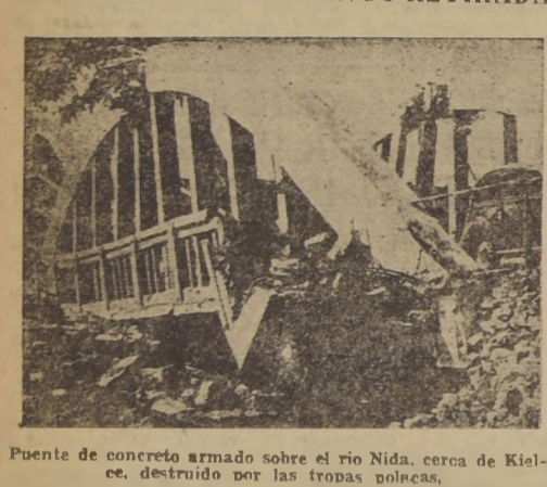
Puente de concreto armado sobre el Rio Nida, cerca de Kielce, destruido por las tropas polacas.
