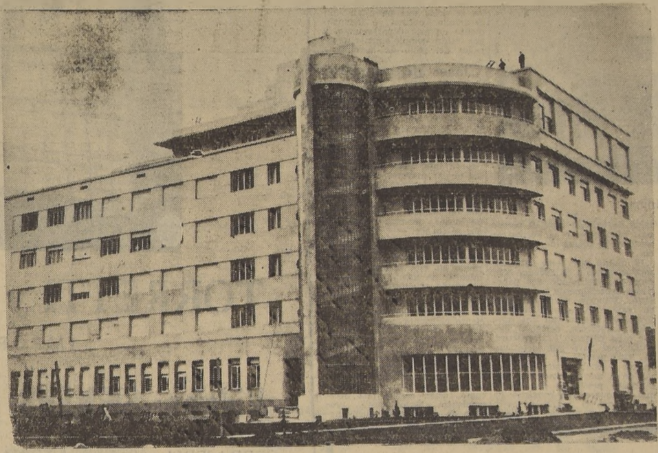
El magnífico edificio de la Clínica Santa María
