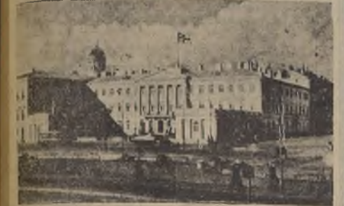
El hermoso palacio del Presidente de la República. Derecha, la estación del ferrocarril, célebre creación arquitectónica
