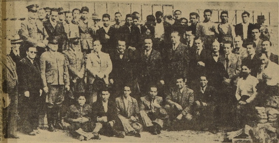
Ministro del Interior, el Intendente de O'Higgins, Jefes de Carabineros y otros invitados a la Fiesta de los Tijerales, acompañados de un grupo de obreros que trabajan en la construcción de la Población.
