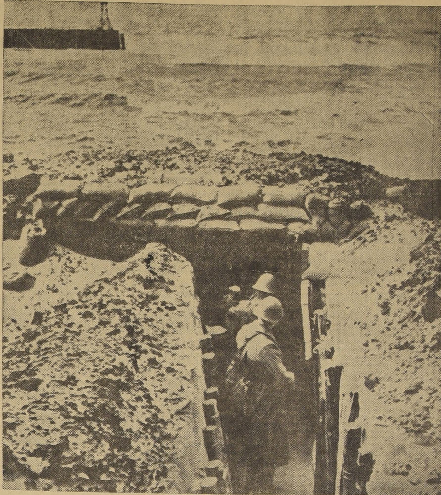
A causa de que parte del territorio holandés se encuentra a nivel más bajo que el del mar no ha sido posible construir defensas subterráneas.—El grabado muestra una línea de trincheras excavadas a orillas del mar, que se halla coronada por un parapeto de este sistema de defensa se completa con la línea de fortines que se extiende hasta Maastricht en la frontera belga y que continúa dentro de Bélgica con las obras fortificadas construidas en los bordes del canal Albert
