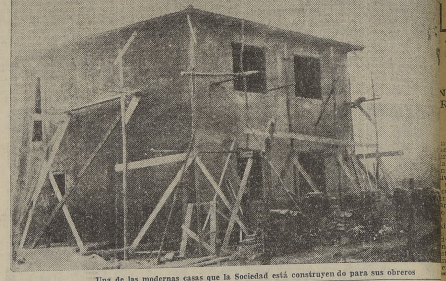
Una de las modernas casas que la Sociedad está construyendo para sus obreros
