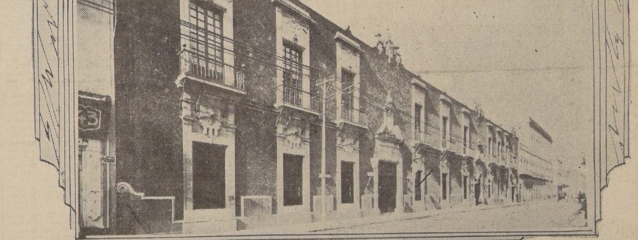
1.—Casa Amigas de la Obrera. 2.—Desayunos infantiles en un Jardín de Niños. 3.—Unidad de Cancerología: fachada posterior. 4.—Unidad Antituberculosa: pabellones. 5.—Casa-Cuna. Con el cine infantil. 6.—Edificio de la Beneficencia Pública.
