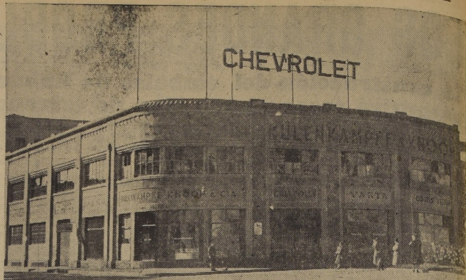
Edificio que ocupan las oficinas y el salón de exhibiciones de la firma Kulenkampff, Knoop, en la Av. Brasil esquina de Bellavista
