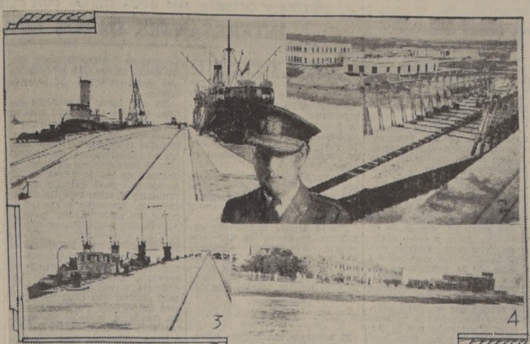
1.—Muelles de reparaciones del Arsenal Naval.—2. Varadero del Arsenal Naval y base de submarinos.—3. Arsenal Naval, muelle de reparaciones.—4. Escuela Naval del Perú. La Punta.—5. Comandante C. A. P. Carlos Warhburn Salas, jefe III Sección del Estado Mayor de Aeronautía.
