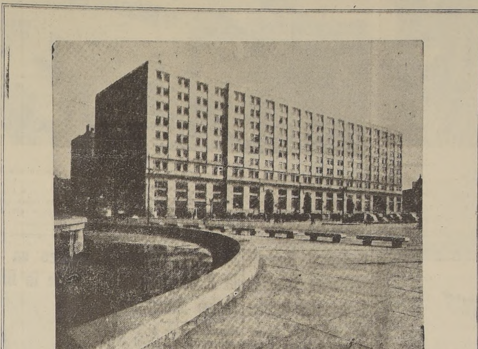
Edificio, Teatinos 20, esquina Avenida Bernardo O'Higgins, (entre piso) donde la firma Zeballos, Blanco y Cía. Ltda. tiene instalada sus oficinas y Sala de Exposición y Ventas.
