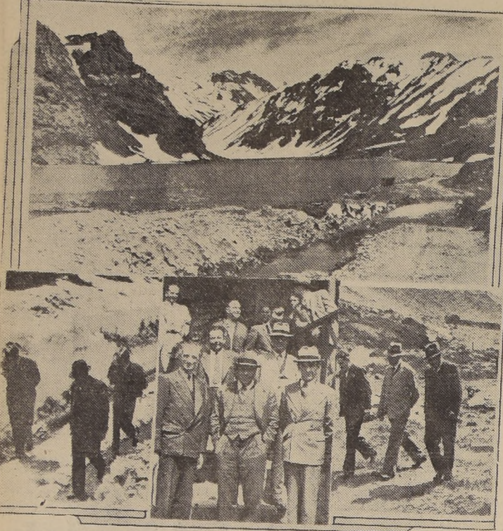
El Ministro del Interior y autoridades, durante la visita que efectuaron ayer, a las obras de la Empresa de Agua Potable
