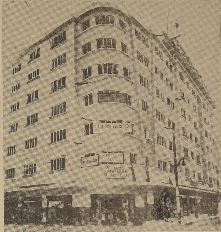
Vista general del edificio
