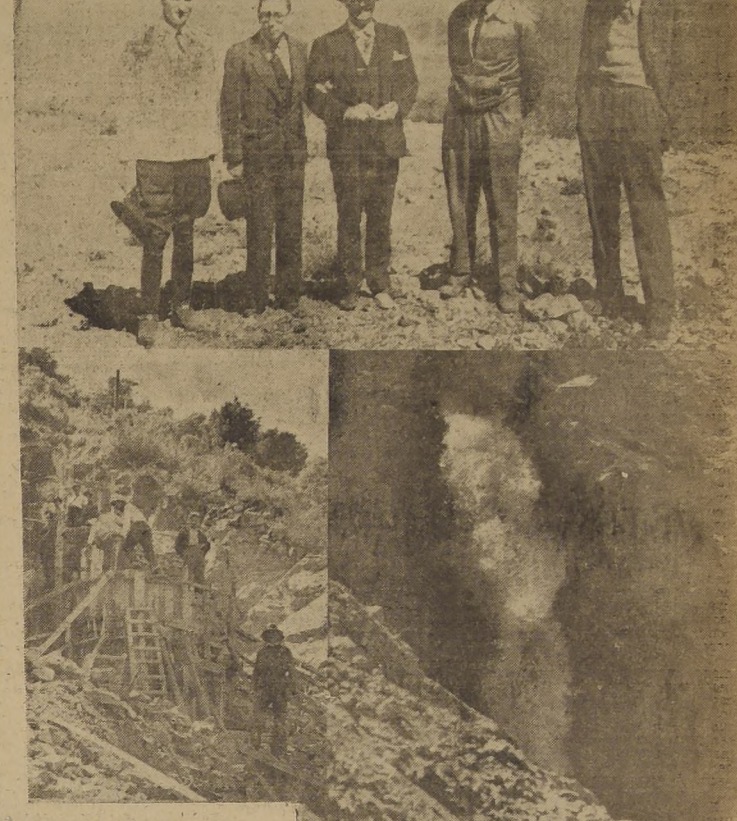
Arriba, miembros de la comiti. va. Abajo, a la derecha, grupo de obreros que trabaja en las obras. A la izquierda un derrumbe
