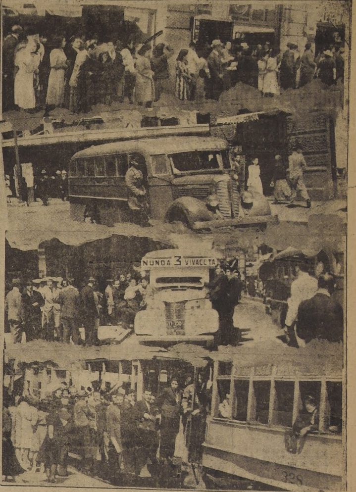
El grabado muestra la aglomeración que se produjo en los medios de movilización colectiva, a causa de la huelga de los choferes y cobradores de autobuses y micros.
