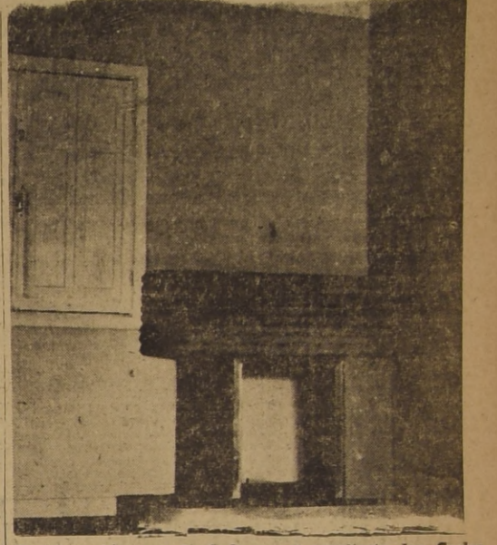
Novísima chimenea, diseñada por el arquitecto don Carlos Díaz, en cuya construcción se ha utilizado ladrillos pulidos, mármol reconstituido y acero al cromo.
