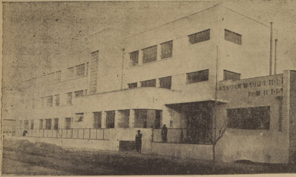
Fachada del nuevo edificio para la Escuela de Hombres de Puente Alto
