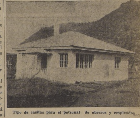
Tipo de casitas para el personal de obreros y empleados
