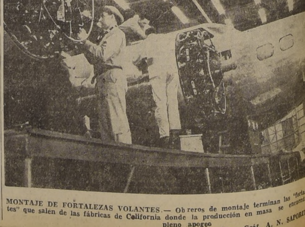
MONTAJE DE FORTALEZAS VOLANTES — Obreros de montaje terminan las "fortalezas" que salen de las fábricas de California donde la producción en masa se encuentra en pleno apogeo. Serv. Grát. A. N. S. FORBETT
