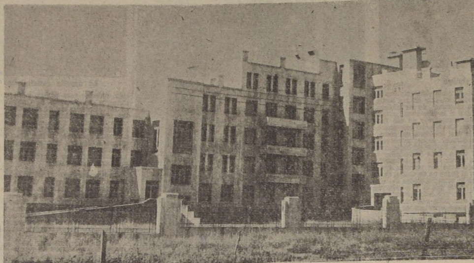
Vista del Hospital por calle Simón Bolívar
