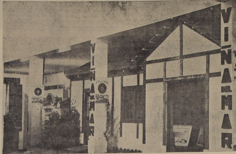
Fachada del chalet que presentan la Municipalidad y el Casino de Viña del Mar
