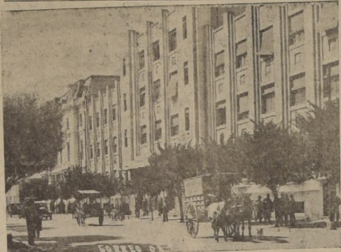
Calle 1 Oriente, frente a la Plaza de Armas. Edificio Correos e Intendencia, Talca
