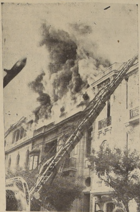
El edificio de la Dirección de Información es presa de las llamas
