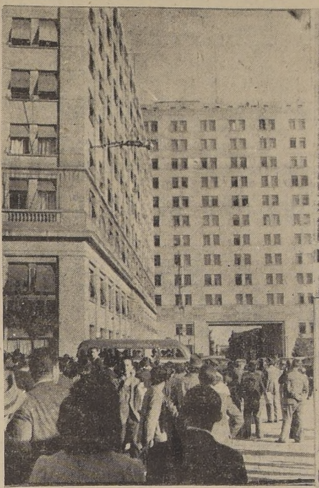
Público que se estacionó frente al edificio del Ministerio de Defensa, en la creencia de que había sufrido serios daños. En los primeros momentos del temblor, numerosas personas acudían a refugiarse en la Plaza Constitución, presas de visible pánico. Las pizarras de LA NACION informan de las primeras noticias.
