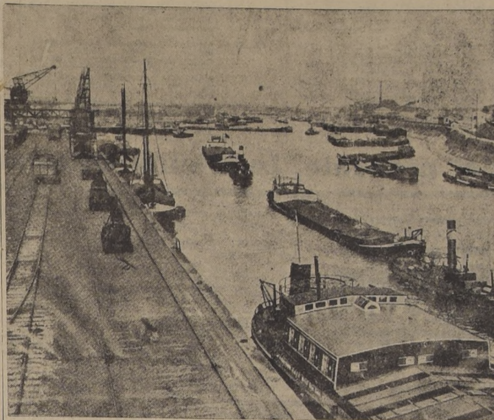
El puerto de Duisburg (situado en el Rhin cerca de la confluencia con el río Ruhr), que se encuentra parcialmente inundado.
