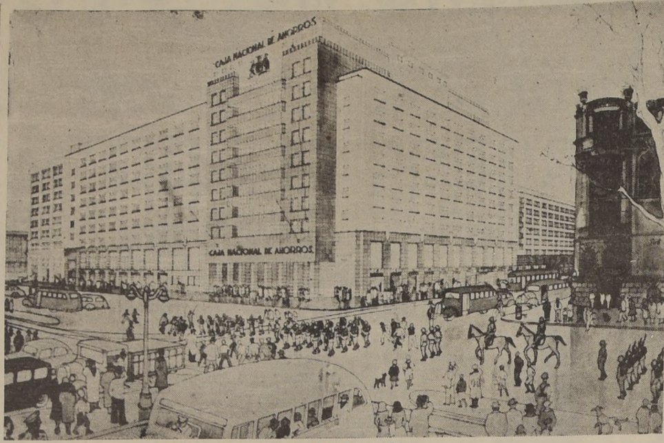
Imponente aspecto que presentará el futuro edificio
