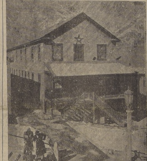
Hotel de Sewell, donde habitan los empleados de la Compañía
