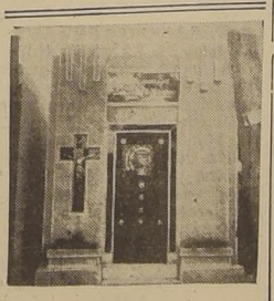
Familia JULIO HEIREMANS LYON. Construido por: JOSE PAINE ARRIETA.
