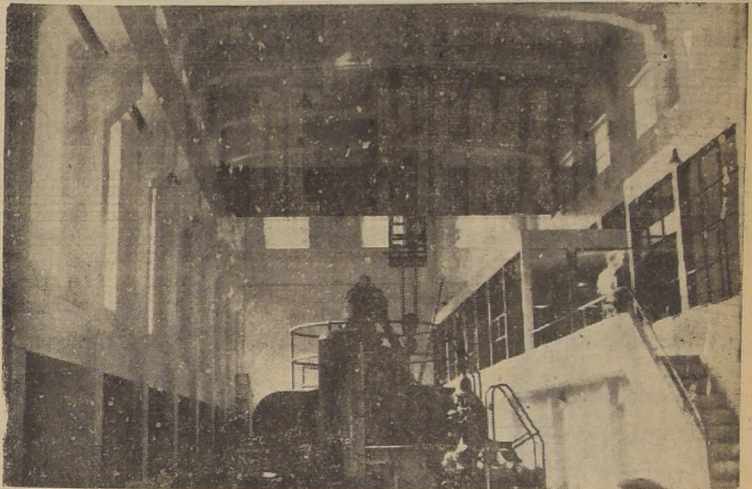
Interior de la Casa de Máquinas
