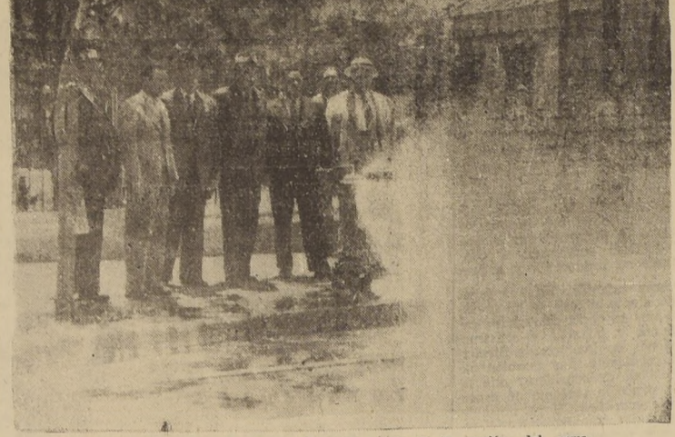
Un grupo conectado a las nuevas obras da prueba de la presión del agua.
