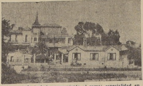
Se ejecuta todo trabajo concerniente al ramo: especialidad en atención a lavados rápidos para vapores, Hoteles y Residenciales.
