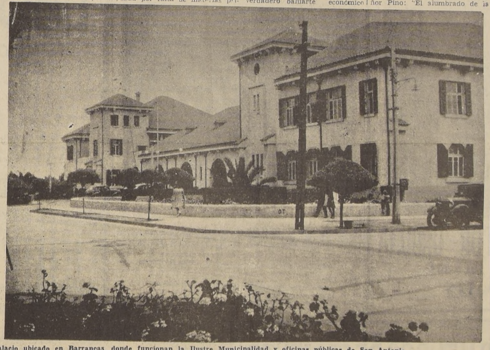
Palacio ubicado en Barrancas, donde funcionan la Ilustre Municipalidad y oficinas públicas de San Antonio (Foto J. Torres Valencia)
