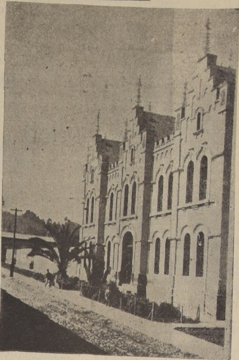
Cárcel-Presidio de La Serena, cuyo edificio fue proyectado por el Presidente Balmaceda y terminado en 1915
