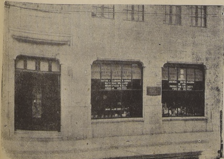
Parte del edificio ocupado por oficinas, salas de venta y bodegas
