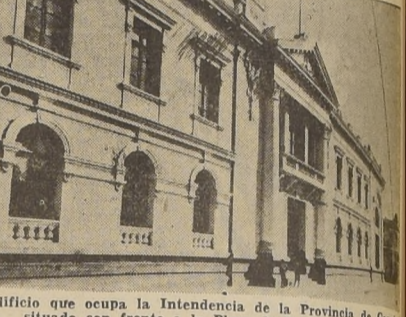
Edificio que ocupa la Intendencia de la Provincia de Coquimbo, situado con frente a la Plaza de Armas de La Serena
