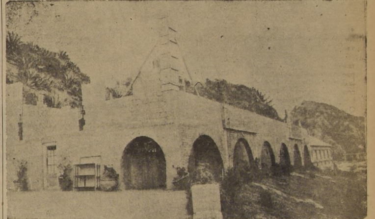
Fundaciones y parte del primer piso del hotel proyectado
