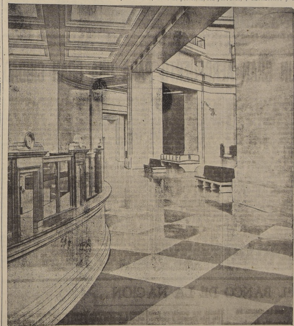
Interior del edificio. Cajas de atención al público
