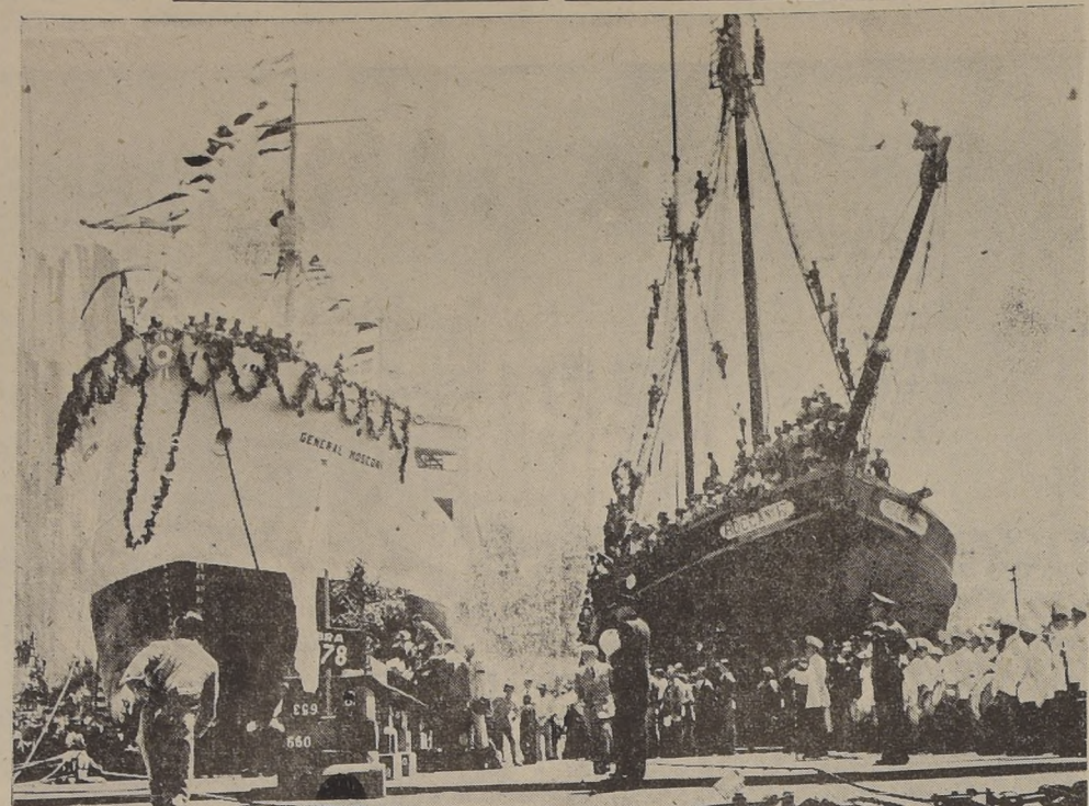
LA INDUSTRIA NAVIERA ARGENTINA. — En los astilleros, argentinos se construyen buques petroleros y de carga con lo cual las actividades del cabotaje están recibiendo un nuevo y poderoso impulso. Las nuevas unidades están ya en servicio en los ríos navegables de la República Argentina
