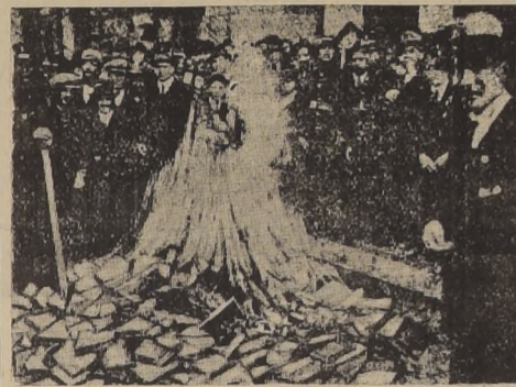
La biblioteca de la Federación es incendiada en la primera cuadrada de Ahumada, ante la indiferencia de la policía
