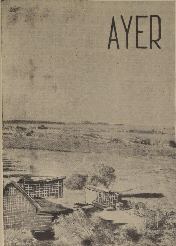
Vista del predio de Juan Soldado, antes de iniciarse los trabajos
