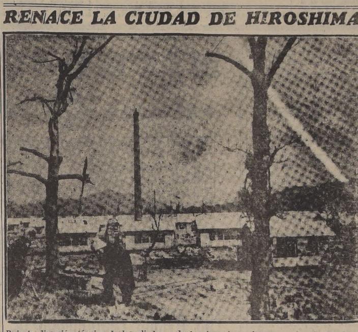
Bajo la dirección técnica de los aliados y de los Ingenieros japoneses, la ciudad de Hiroshima renace de sus ruinas. Las casas que se levantan son de material ligero y de rápida construcción.
