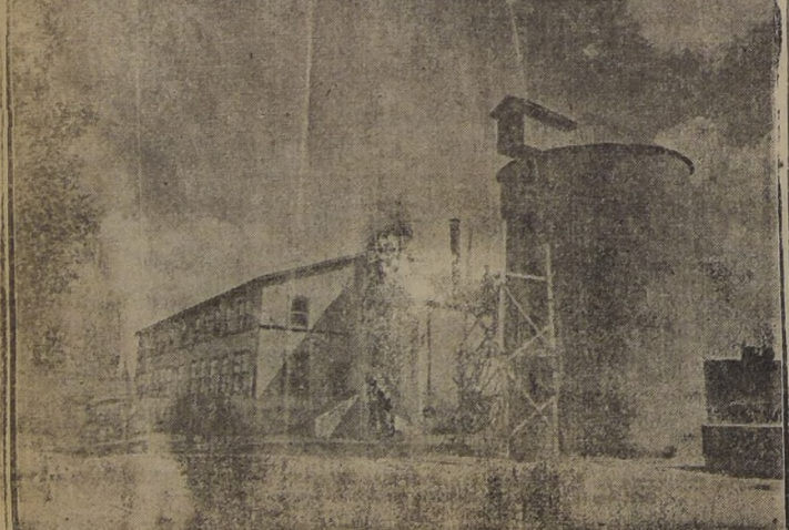
Establo con silo anexo, con capacidad para almacenar 220 toneladas de pasto
