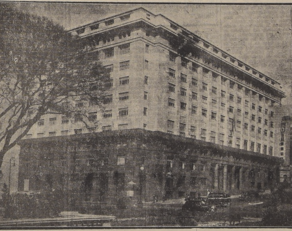
Edificio del Ministerio de Hacienda
