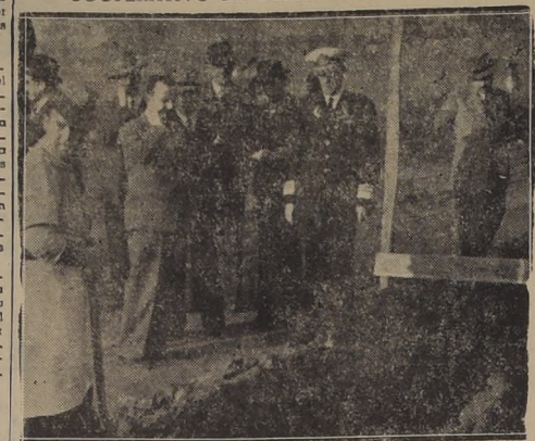
El Ministro de Obras Públicas, general Tovarias, observa la construcción del alcantarillado de Conchalí.
