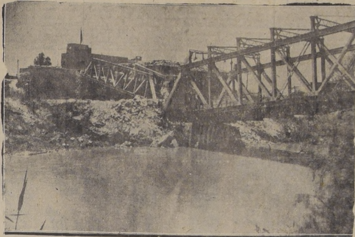
El puente Allenby, que unía a Palestina con Transjordania, destruido por los terroristas después de sostener un combato con las guardias.
