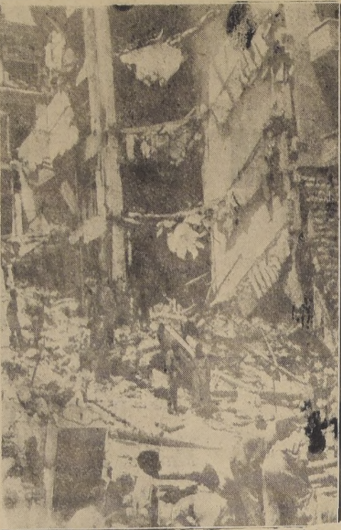
Atentado terrorista contra el cuartel general británico.— Vista del estado en que quedó el Hotel Rey David, de esta ciudad, después del atentado terrorista, a consecuencia del cual resultaron decenas de muertos y heridos. Esta es la parte donde se encontraban las oficinas del cuartel general y de las oficinas del Gobierno. Se culpa a los terroristas semitas de esta tragedia.— (FOTO ACME).
