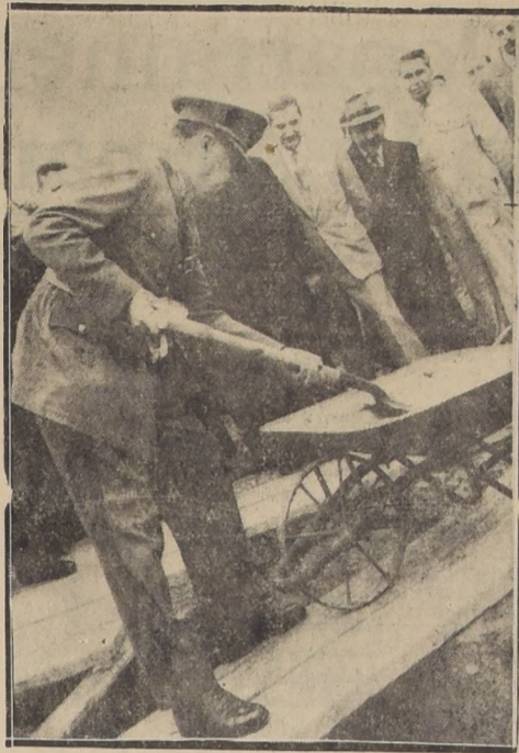
El Ministro de Defensa Nacional, general señor Carrasco, coloca las primeras paladas de concreto de la futura Población "Manuel Rodríguez".
