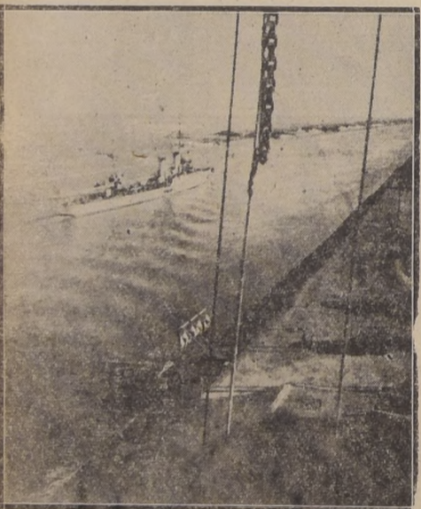
Un torpedero que efectúa la policía de la navegación y el control del Canal de Suez.
