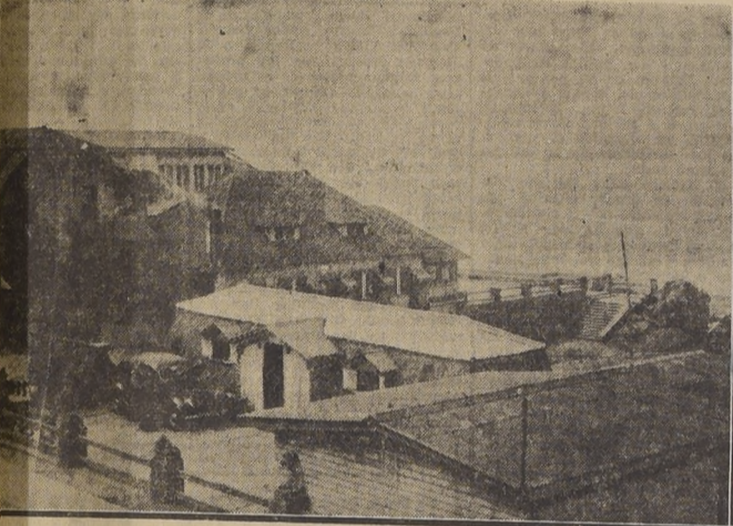
REPOSO LAS CRUCES. — Sanatorio para cardiovasculares situado en el Balmorán de Las Cruces. Es una hermosa casa edificada entre las rocas muy junto al mar, con capacidad de 50 camas para enfermos de ambos sexos. — En este mes se entregaron los trabajos de modernización mayor comodidad a los reposantes. — Cuenta con un personal especializado a cargo de las diversas dietas a que deben someterse los enfermos cardiovasculares.
