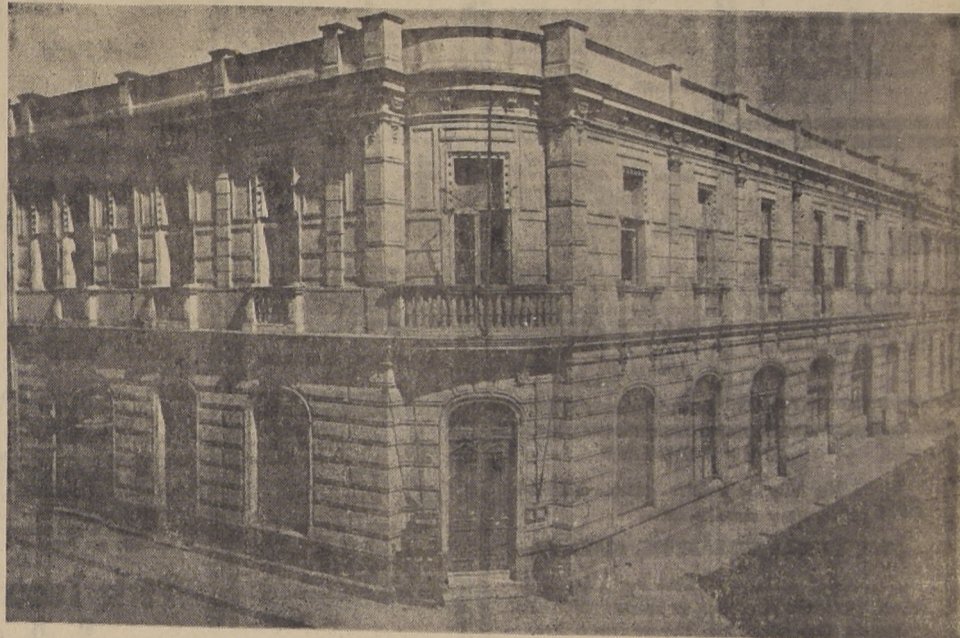
Fachada del edificio que ocupa el Servicio Médico Nacional de Empleados. — Este amplio local está ubicado en Teatinos esquina de Santo Domingo.
